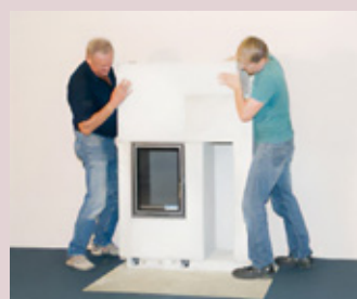
Verkleidungselemente Stück für Stück zusammensetzen und verkleben
