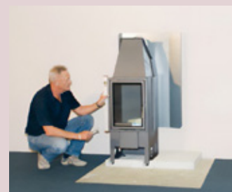
Kamineinsatz mit Wasserwaage einrichten
