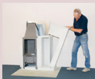
Verkleidungselemente Stück für Stück zusammensetzen und verkleben
